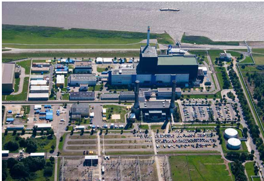
Atomkraftwerk Brunsbüttel, wegen dessen Stilllegung Vattenfall Klage gegen Deutschland einreichte
